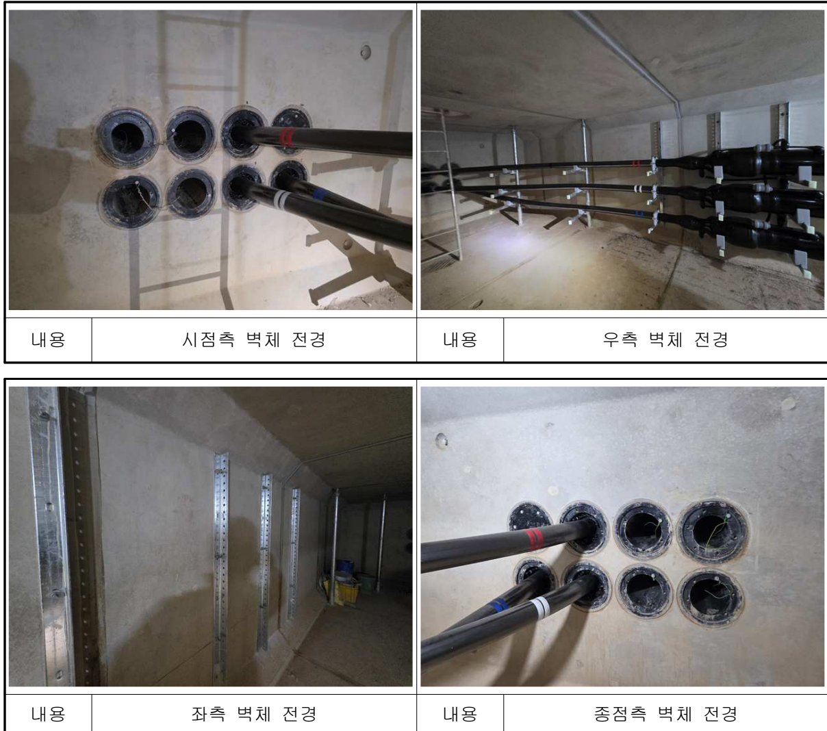
【사진 1.13】 진건~별내#4 전경
