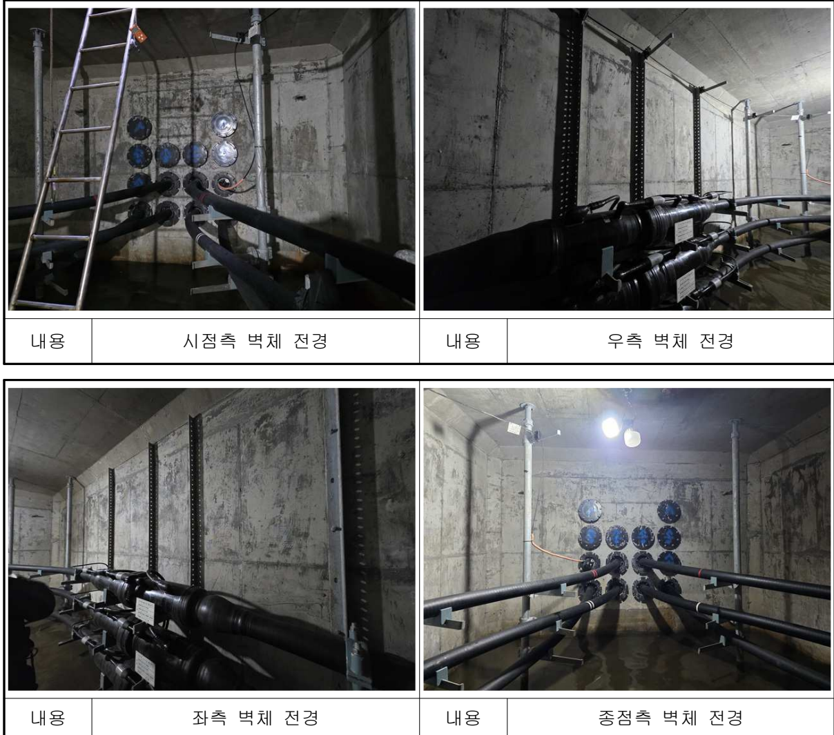
【사진 1.25】 진건~별내#7 전경
