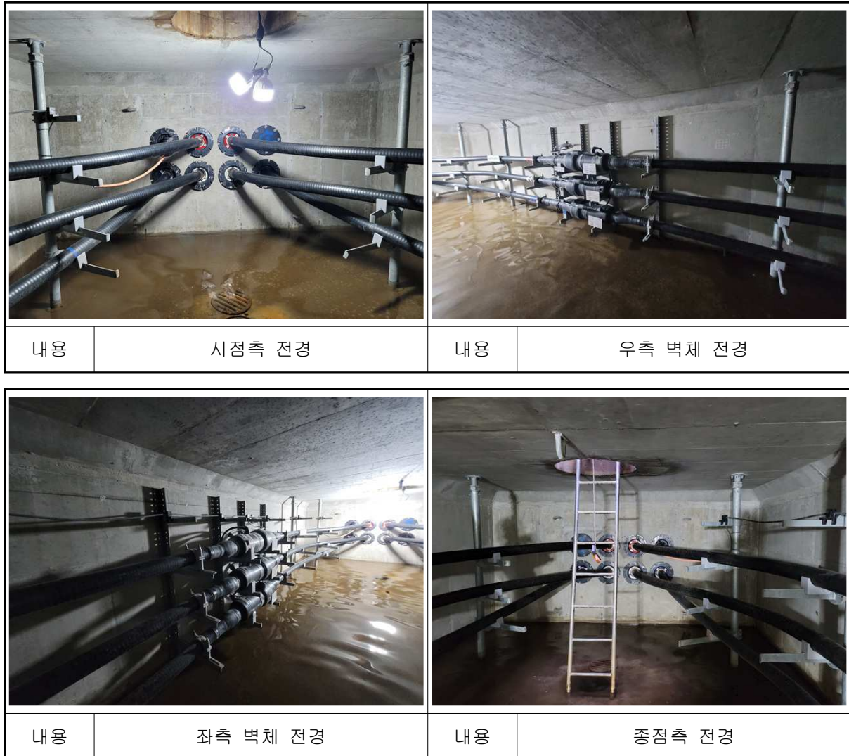
【사진 1.1】 진건~별내#1 전경
