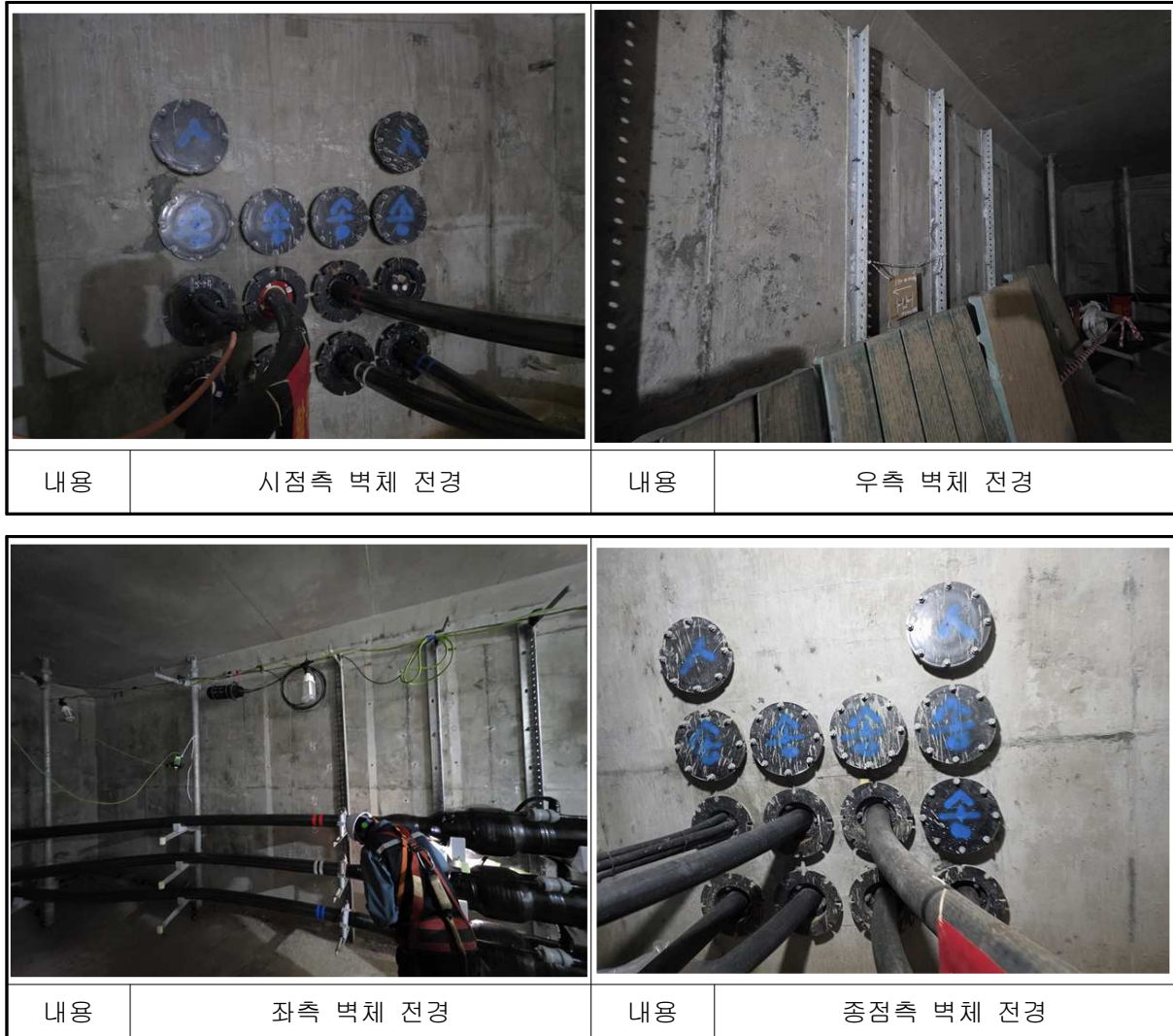
【사진 1.17】 진건~별내#5 전경
