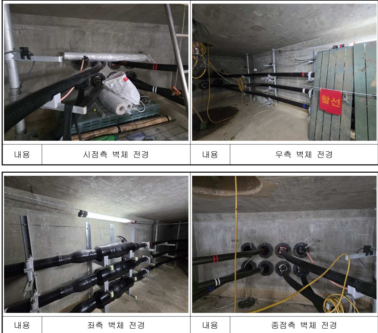
【사진 1.9】 진건~별내#3 전경
