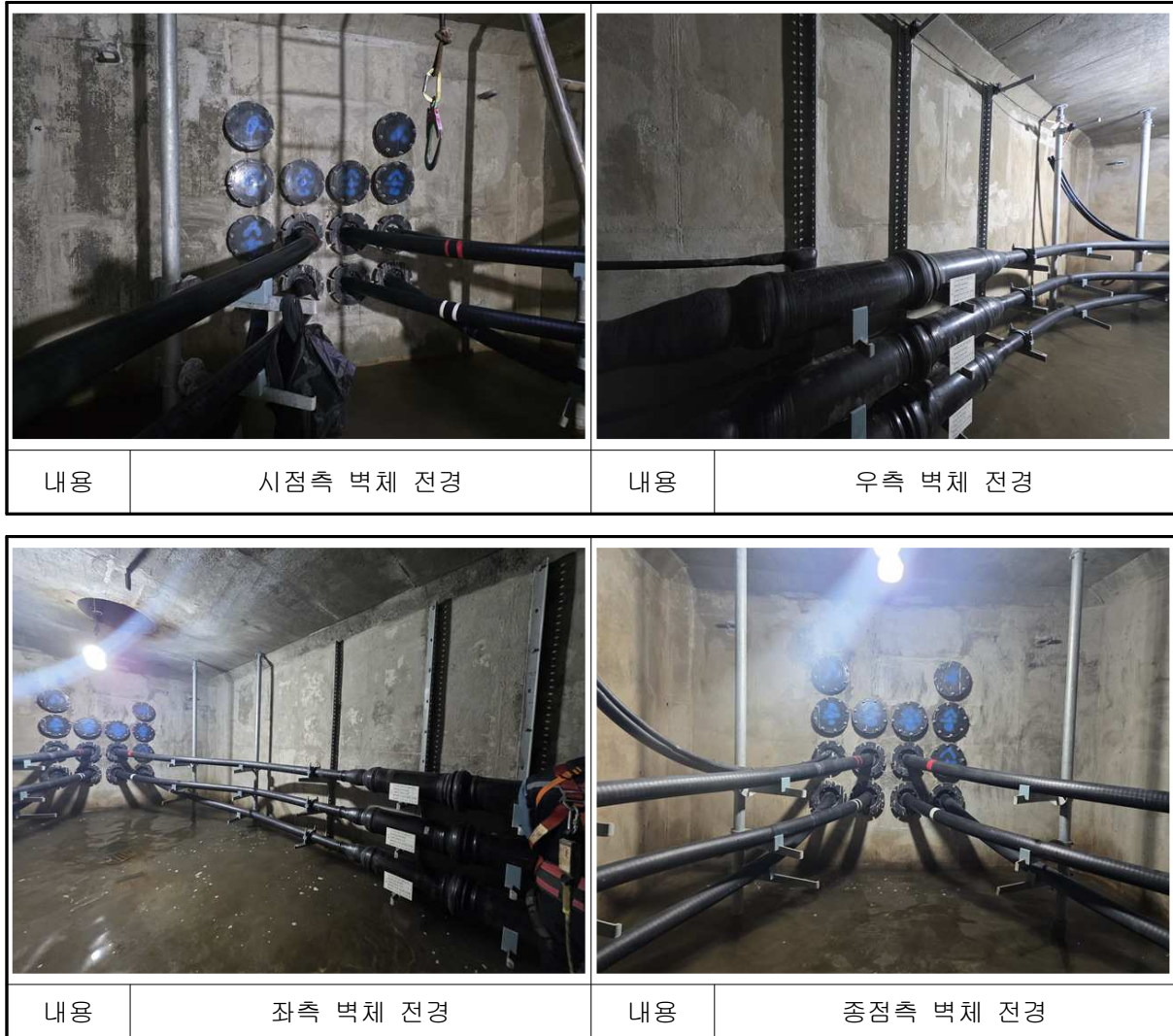
【사진 1.21】 진건~별내#6 전경
