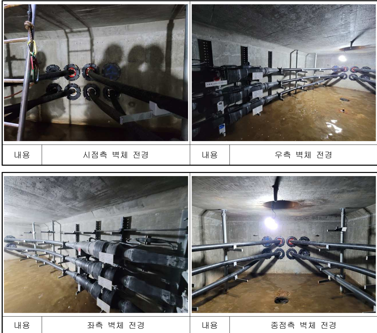
【사진 1.5】 진건~별내#2 전경
